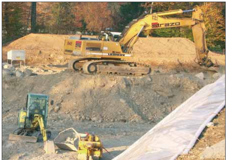
Baustelle in Bassersdorf. Nach dem Willen der Baudirektion künftig ein seltenes Bild.
